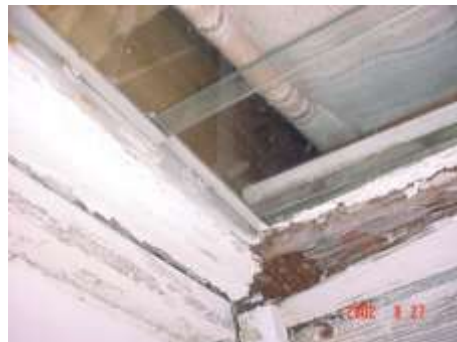
THEATRE PATRIMOINE Expertise termite et dégât des eaux Beau Bassin- ILES MAURICE 2002
